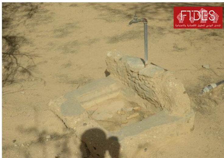
L'école primaire Al-Waha de Segdoud privée d'eau
