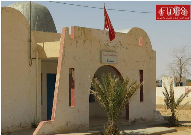
Entrée principale du dispensaire de Segdoud. Photo du 4 Mai 2024
